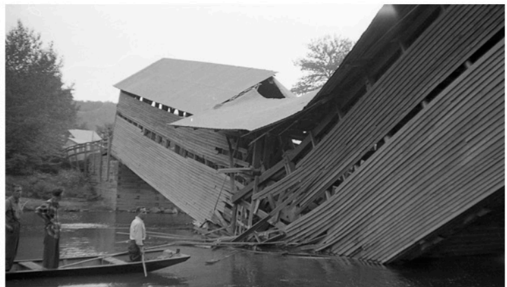
Photo : Effondrement du pont Kearney vers 1955.
